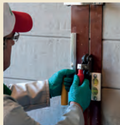
Des outils pour réaliser les joints
